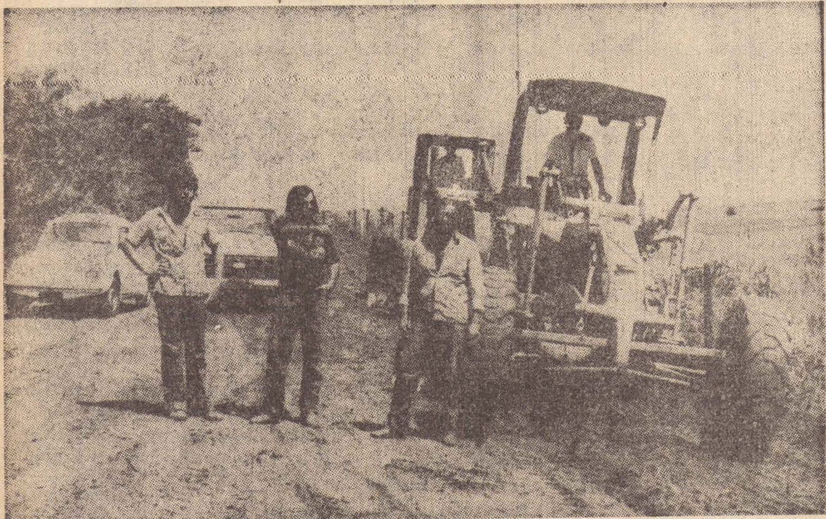
Segundo Dênis e Ilton Costa (foto); as máquinas já estão concluindo o serviço de terraplanagem nas Chacaras Verde Vale
