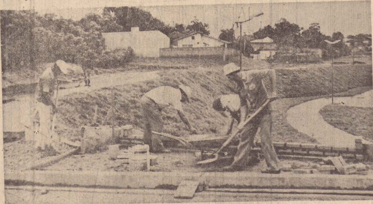
Operarios trabalham no canteiro de obras da Praça Raposo Tavares
