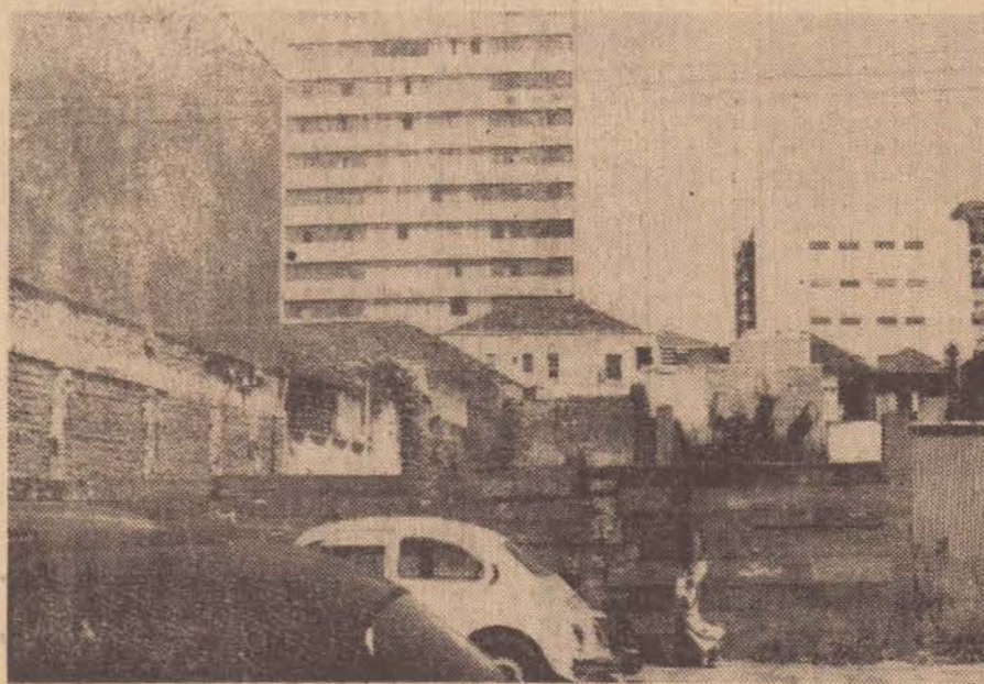
No terreno do BB apenas um tapume.
