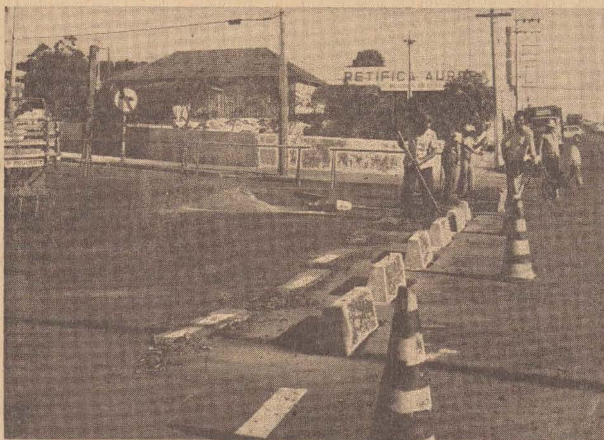
Os operários da prefeitura estavam concluindo ontem a implantação de obstáculos na curva da morte
