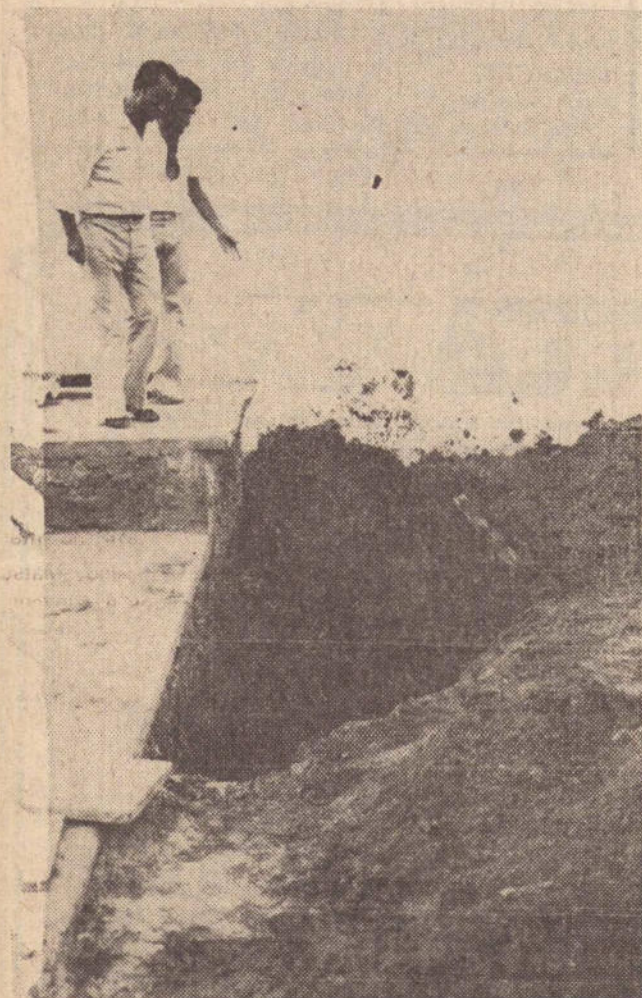
O encarregado da administração Dionizio Catussi, mostra ao vereador Nelson Porto Alegre, a profundidade exigida para a execução da obra.
