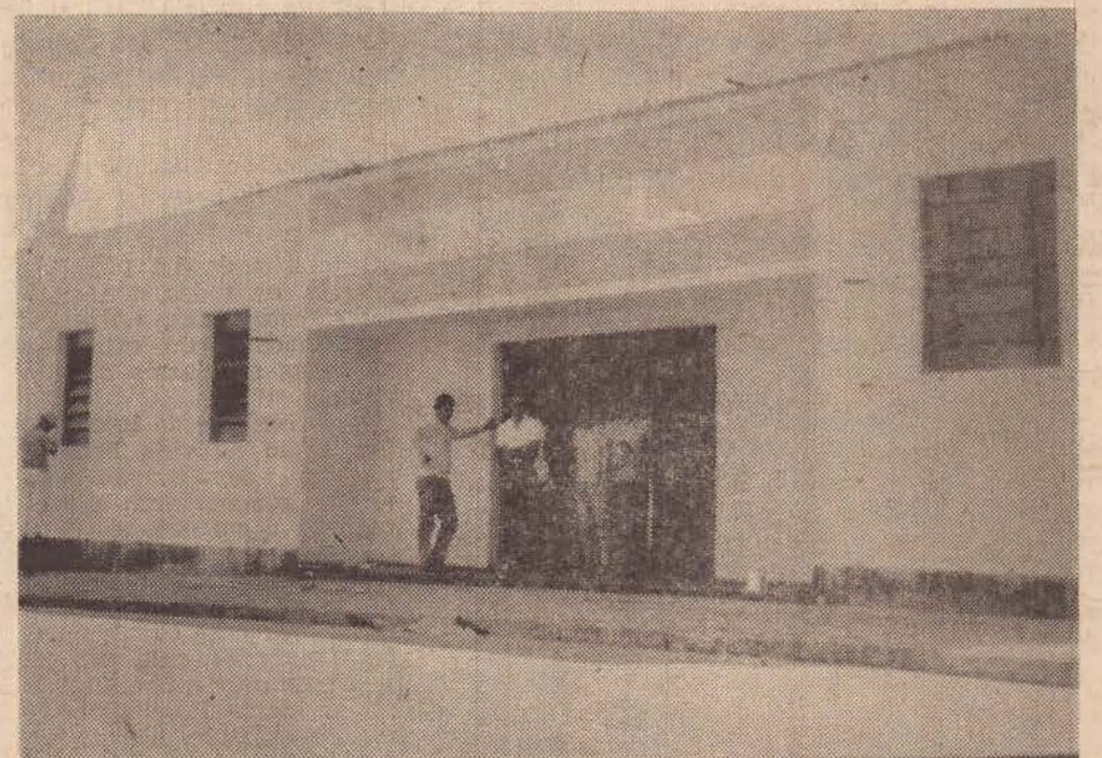
A foto mostra, a entrada da biblioteca municipal de Regente Feijó, que será inaugurada amanhã, no aniversário da cidade. É mais uma realização do prefeito Severino Batista Pereira, que veio assim atender a população estudantil da cidade que cresce vertiginosamente.
