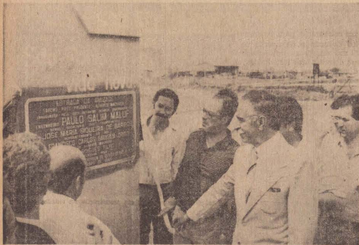
Ao visitar recentemente a região de Presidente Prudente, o Governador Paulo Maluf entregou um dos mais importantes melhoramentos: a Estrada da Amizade, interligando Alvares Machado-Pres. Prudente. Assim, concretizou-se um antigo sonho da população das duas cidades.
