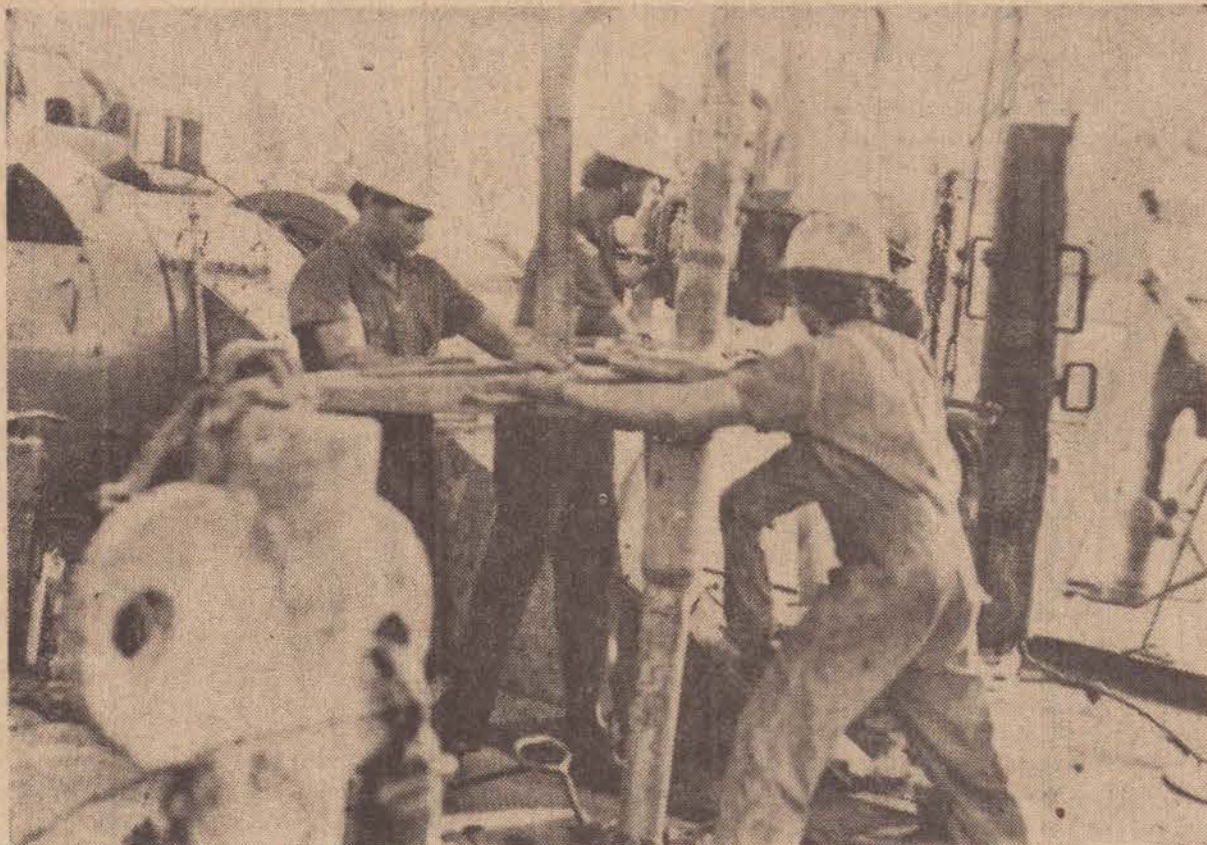
A coluna de tubulação de 4.625 é recolocada no interior do poço, após os testes de quinta-feira.
