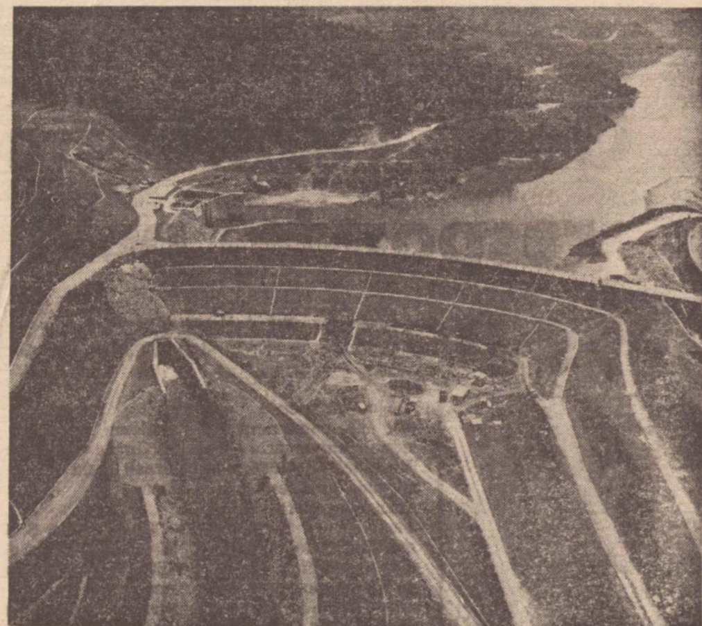
A barragem do Atibainha vai contribuir para a melhoria do abastecimento de água da Capital e da Grande São Paulo, onde o problema é um constante desafio.
