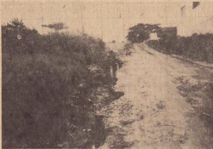
Na Maria da Glória, rapidamente a rua vai virando cratera
