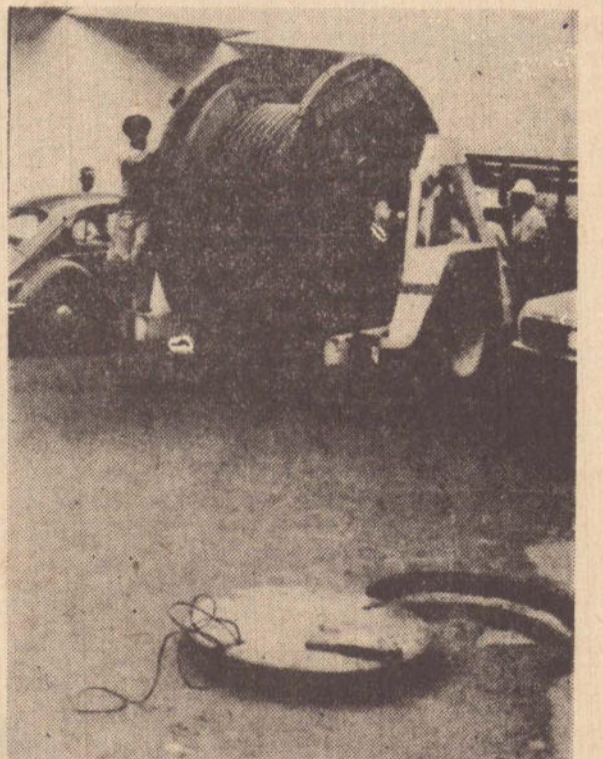
Cabos subterrâneos estão sendo estendidos em
