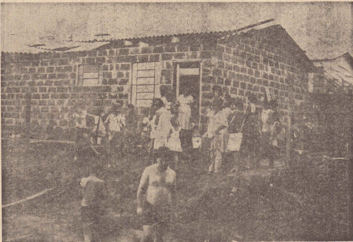
Construção de péssima qualidade, o telhado da casa não suportou a ventania.
