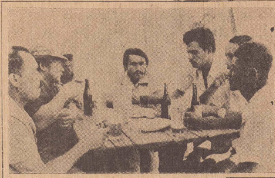
Os trabalhadores que foram homenageados, sábado, e que estão trabalhando a todo vapor. José Nunes é o construtor do balneário. A diretoria do San Fernando está dando outra feição ao clube.
