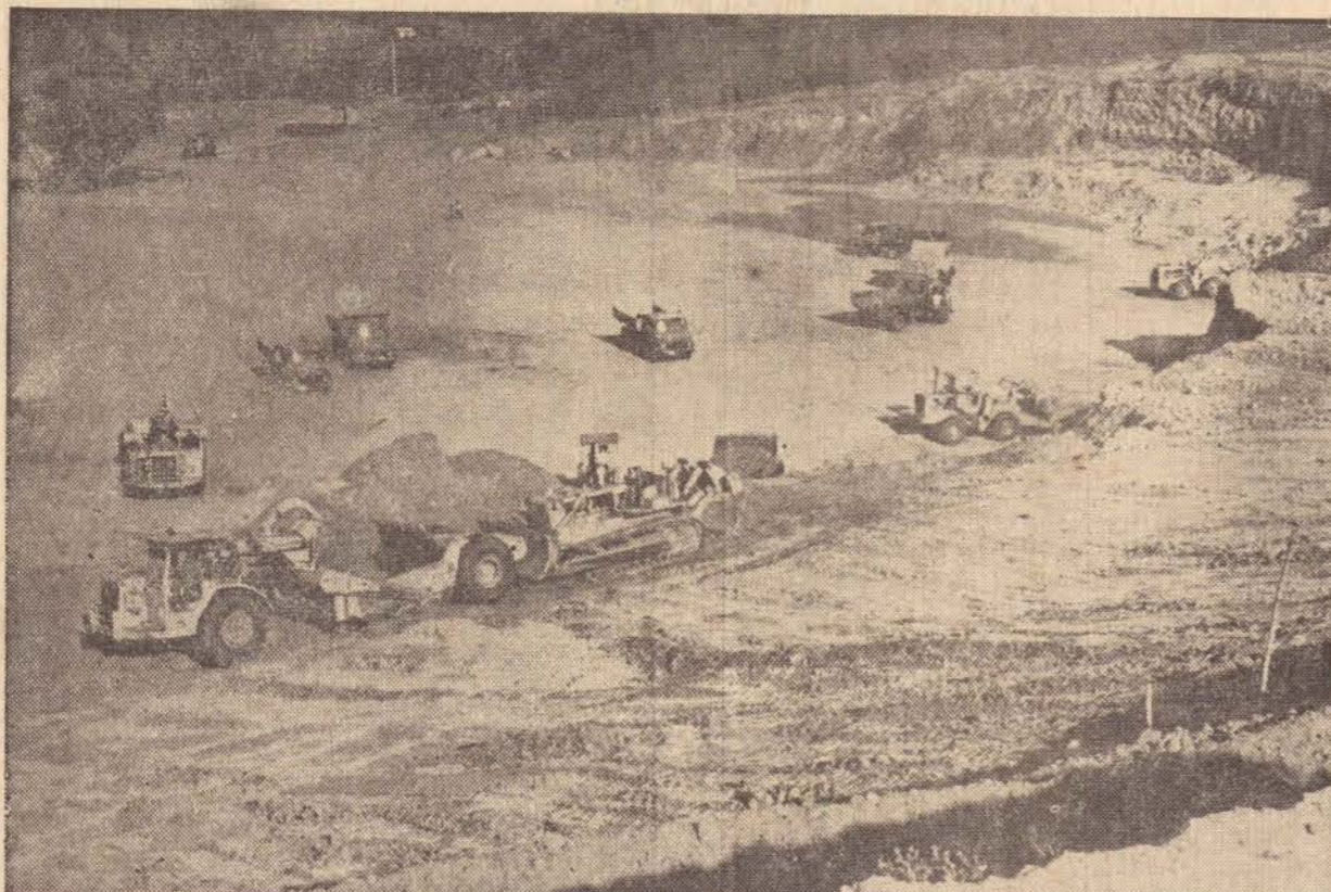
"Depois de construído o aterro e niveladas as rampas, será rápida a instalação de arqui-bancadas pré-moldadas".
