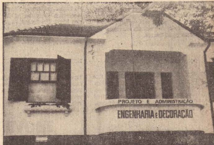
Fachada do prédio onde está instalada, rua Dr. Gurgel, 434
