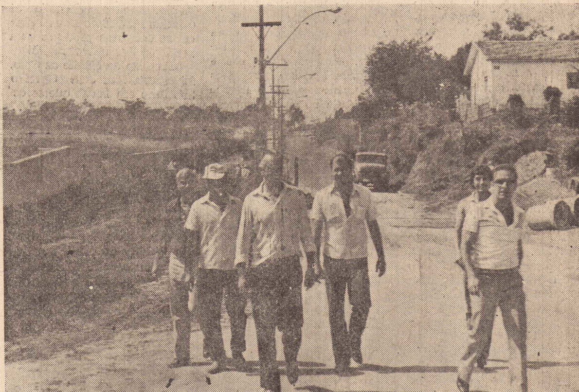
O prefeito inspeciona as obras da nova avenida em construção
