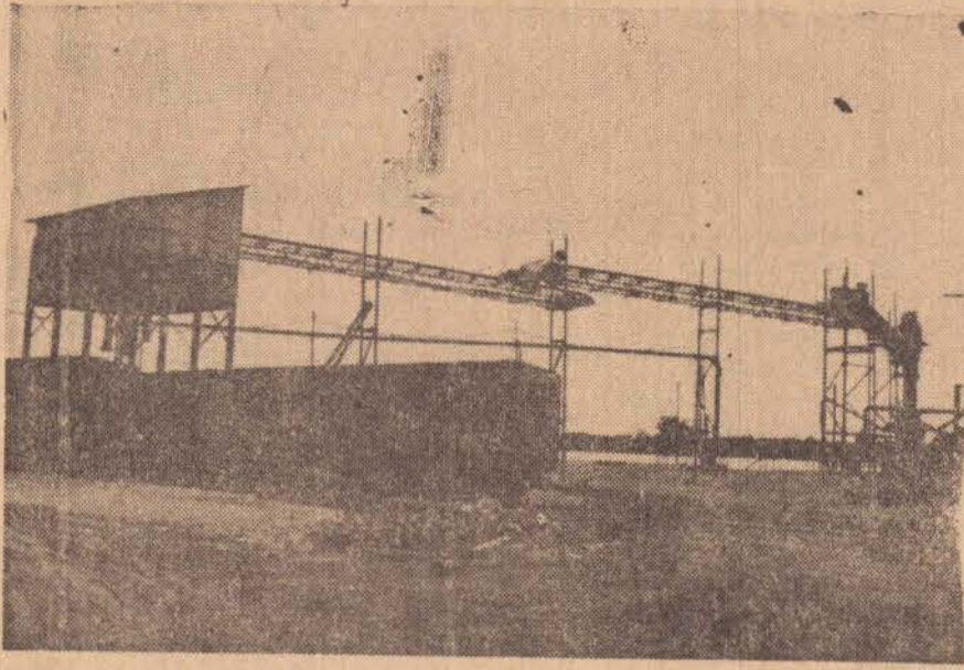
A PORTOBRAS está remodelando o cais do Porto, com sugadores modernos, correias transportadoras, luminárias e outros equipamentos.
