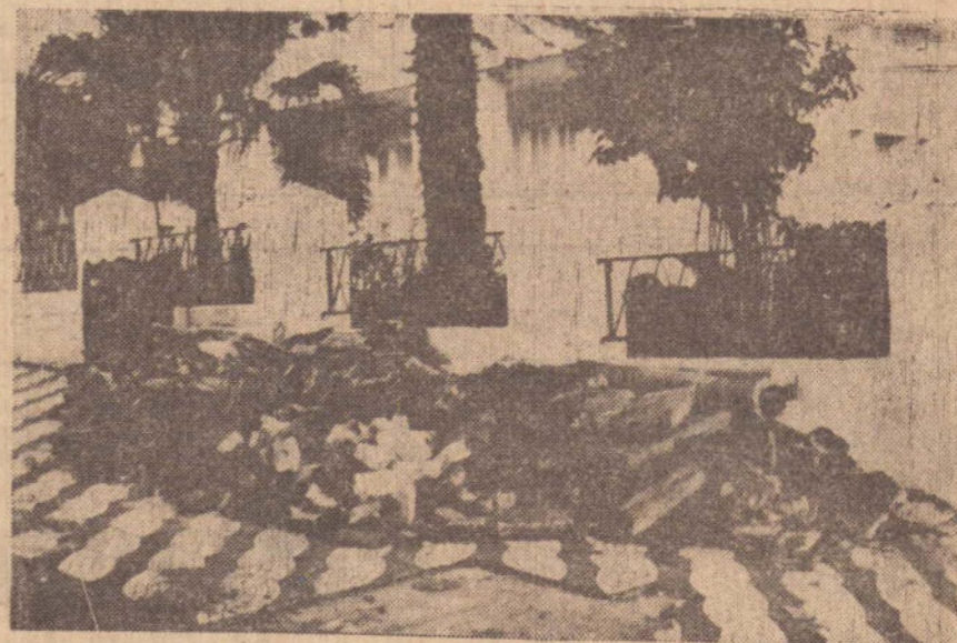
O que já dissemos, a foto comprova. Este é o péssimo costume de atirar para as calçadas e canteiros das avenidas restos de construção. Isto não é lixo e cabe ao próprio morador livrar-se desses monturos.
