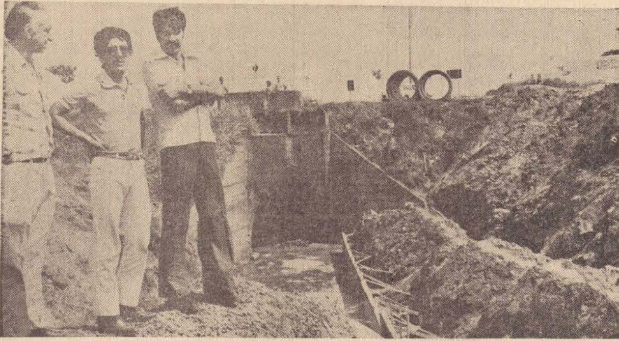
Fechada a galeria será iniciada a construção de uma grande rotatória.
