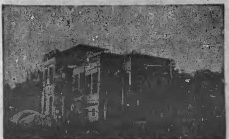
Casas em construção na Villa Cerqueira Cesar.
