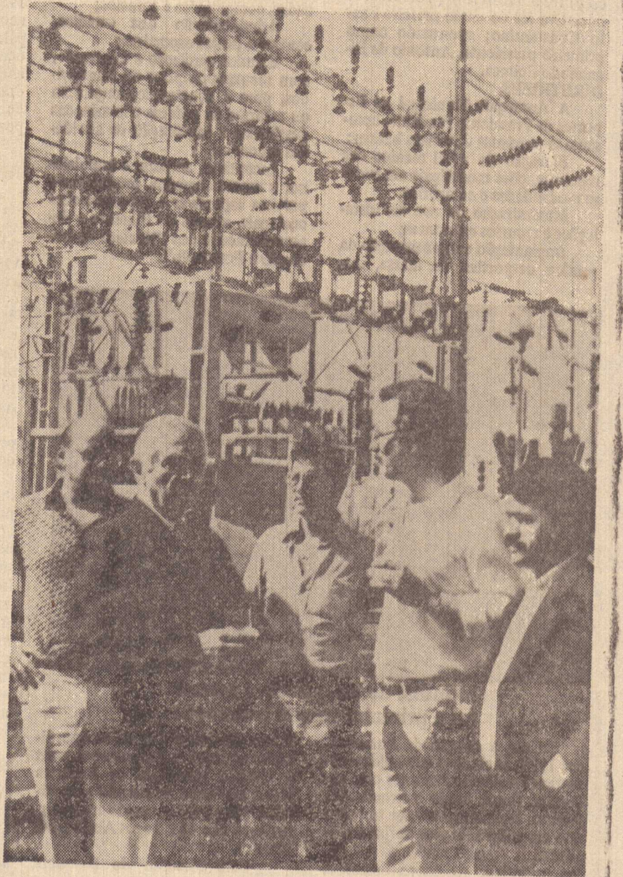
A fotografia acima nos mostra um lance da visita feita pelo prefeito Virgílio Tiezzi Júnior a uma das dependências da Subestação "Florivaldo Leal" da Caiuá, recentemente inaugurada e marcando, na vida da tradicional e cinquentenária concessionária de serviços de energia elétrica, o primeiro de uma série de empreendimentos concretizados e a concretizar na área atendida pela organização. O prefeito prudentino está sendo recepcionado nessa visita pelo próprio presidente da Companhia "Elétrica Caiuá", Dr. Francisco de Paula Machado de Campos, vendo-se também o gerente regional da TELESP, Júlio Adauto Tiezzi e o presidente do Sindicato do Comércio Varejista de Presidente Prudente, Vitalino Crellis. É a presença da Caiuá numa importante fase da vida de nossa cidade, que hoje está completando 66 anos de fundação. Outros investimentos da empresa estão sendo projetados.
