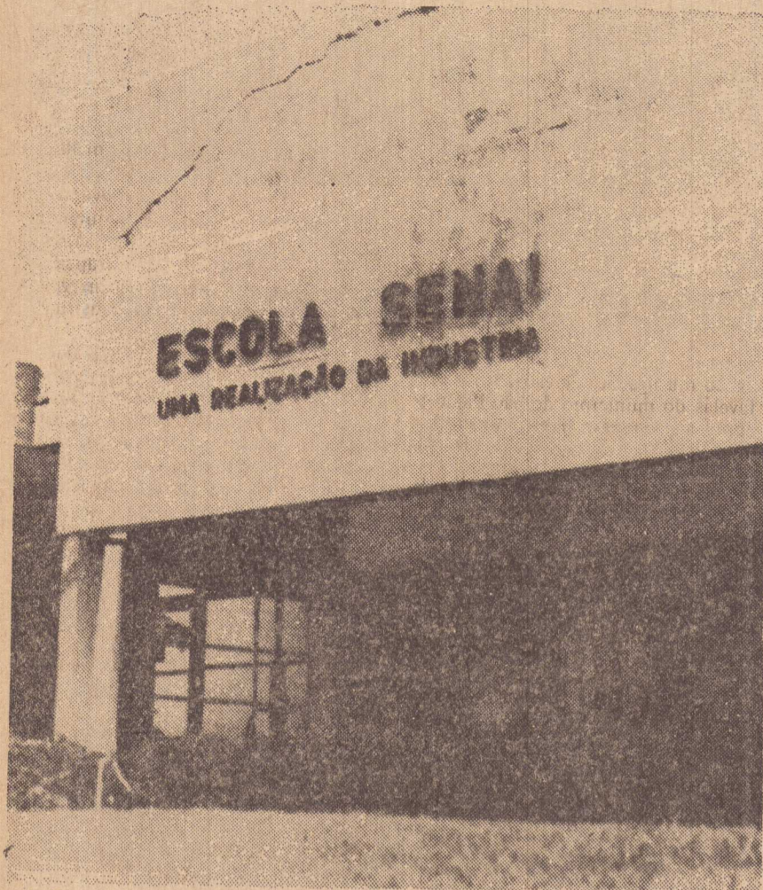
O Senai conta com uma infra estrutura capaz de atender as exigências empresariais.
