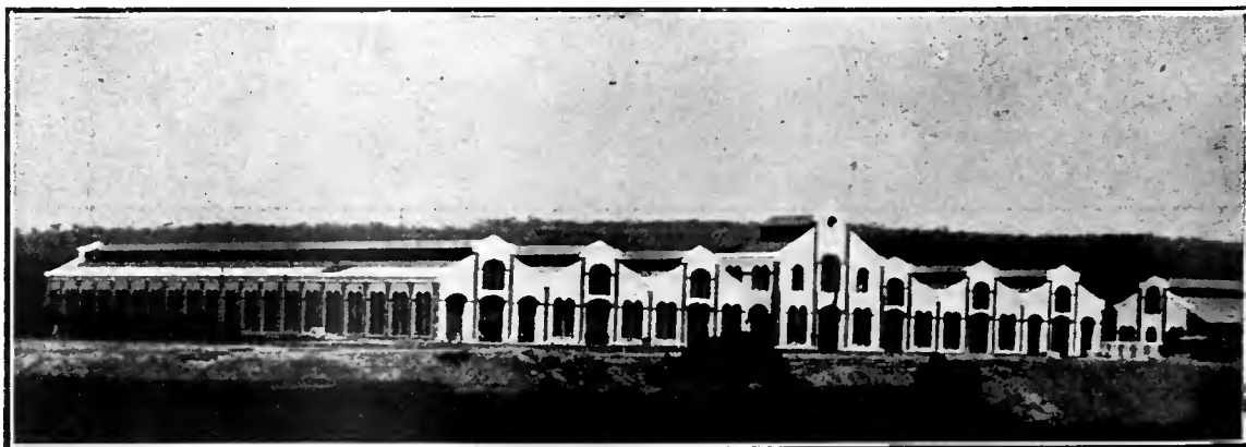
Edificio das Novas oficinas da Estrada de Ferro Noroeste do Brasil, onde estão installados os mais modernos machinismos do genero, toruecidos pelas firmas L. Serva & C. e Costa, Campos & Malta.
