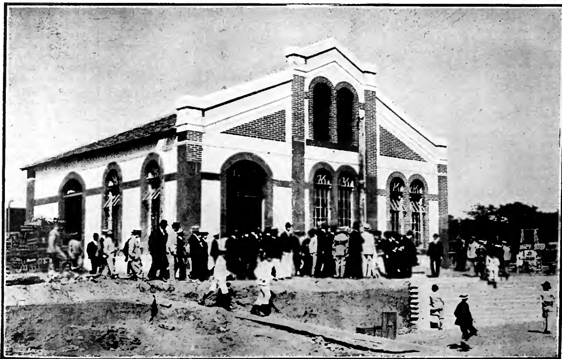
Casa de força das novas oficinas da Estrada de Ferro Noroeste do Brasil em Baurú, também installadas pelas firmas L. Serva & Comp. e Costa, Campõs & Malta.
