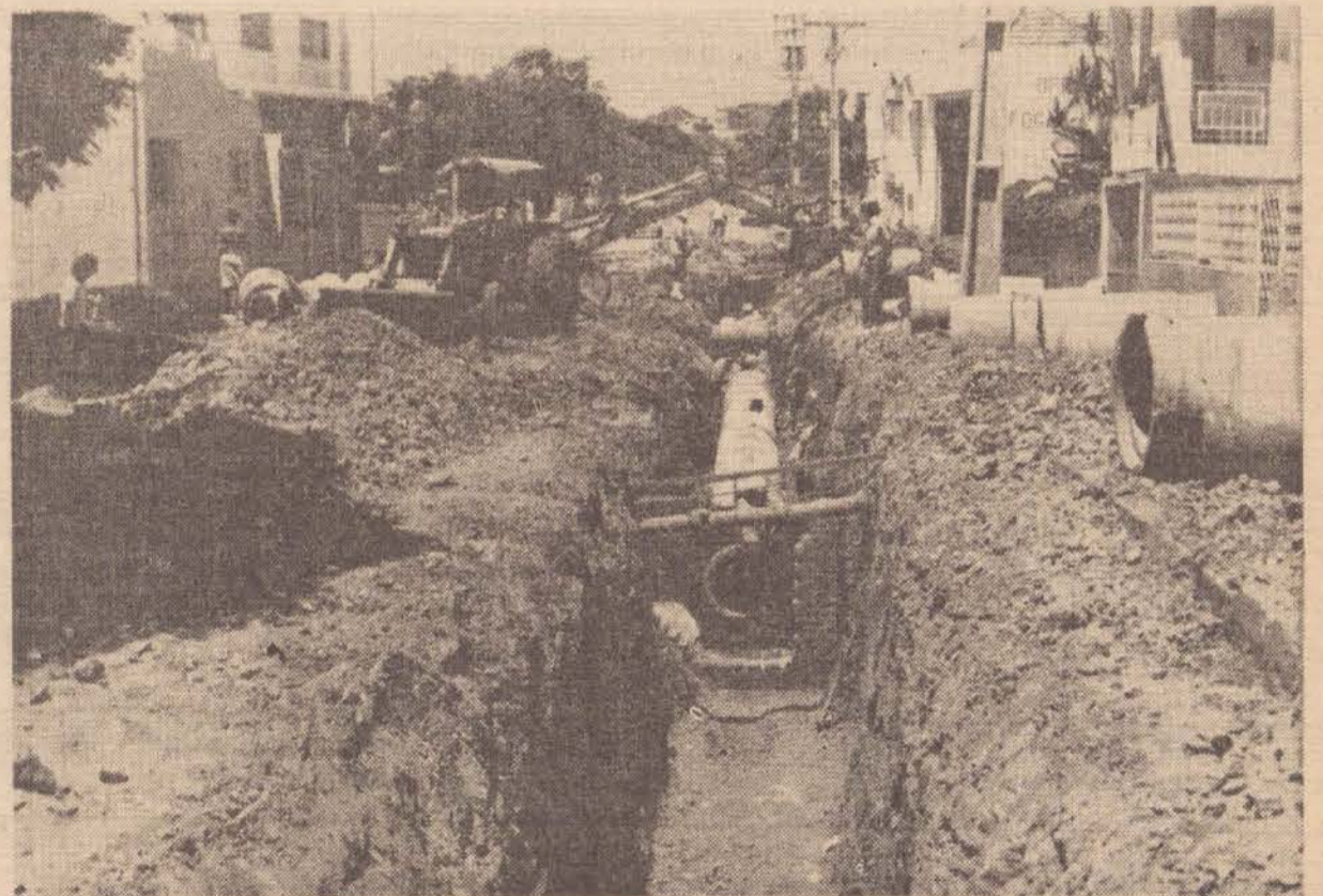
A Rua Alvares Machado desafiou todas as administrações, mas o grave problema das enchentes na fase das chuvas, vai desaparecer com estas obras de saneamento.
