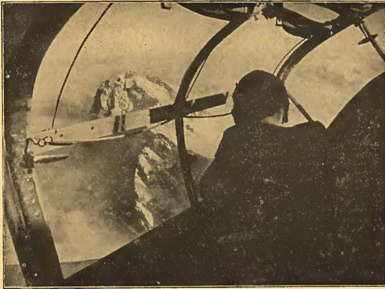
Toda a arma aérea germânica foi equipada com o novo vidro plexi alemão. Plexi não só oferece a vantagem do reduzido peso e da alta segurança contra rupturas, mas pôde ser adaptado às formas requeridas pela estrutura dos aviões.
