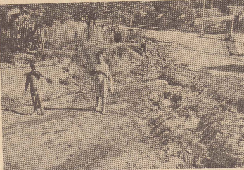
Na avenida Ibrahim Nobre o esgoto a céu aberto
