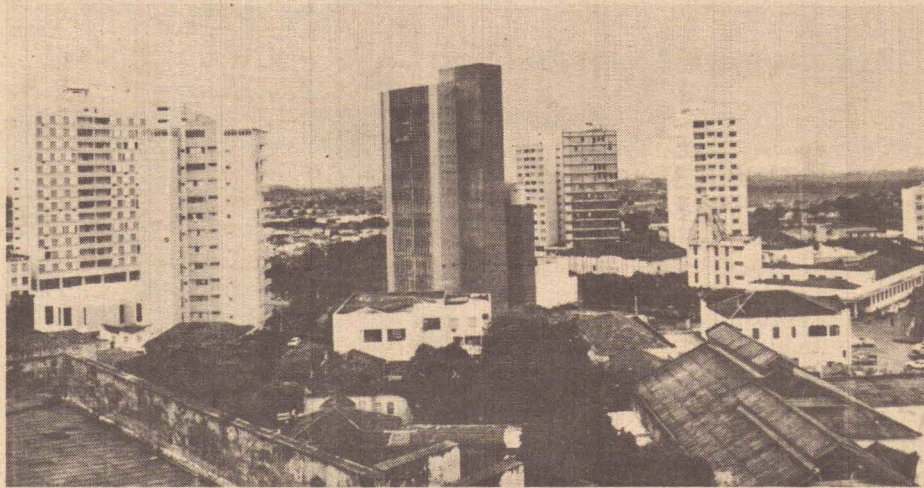
Araçatuba realiza importantes obras na área urbana.
