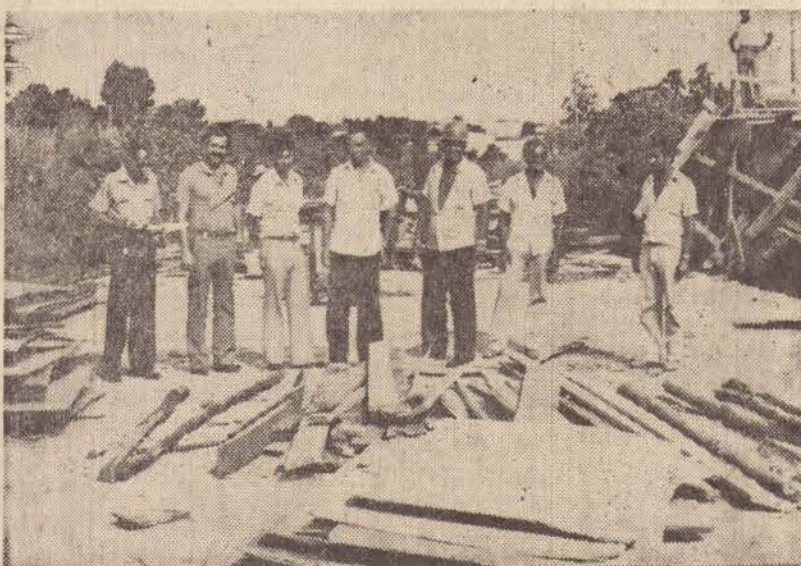
O DER já realiza a infra-estrutura para a construção da grande praça rotatória.
