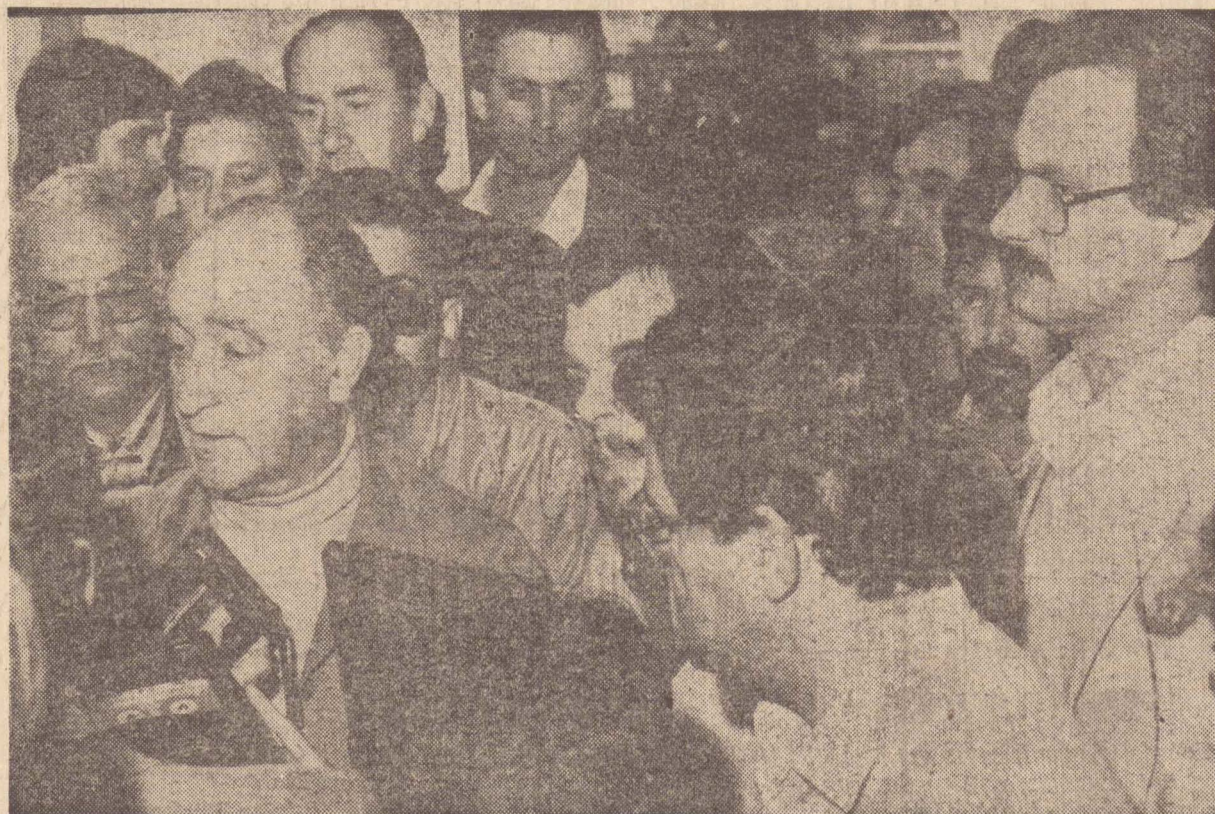
Montoro: terra para os que trabalham nela.
