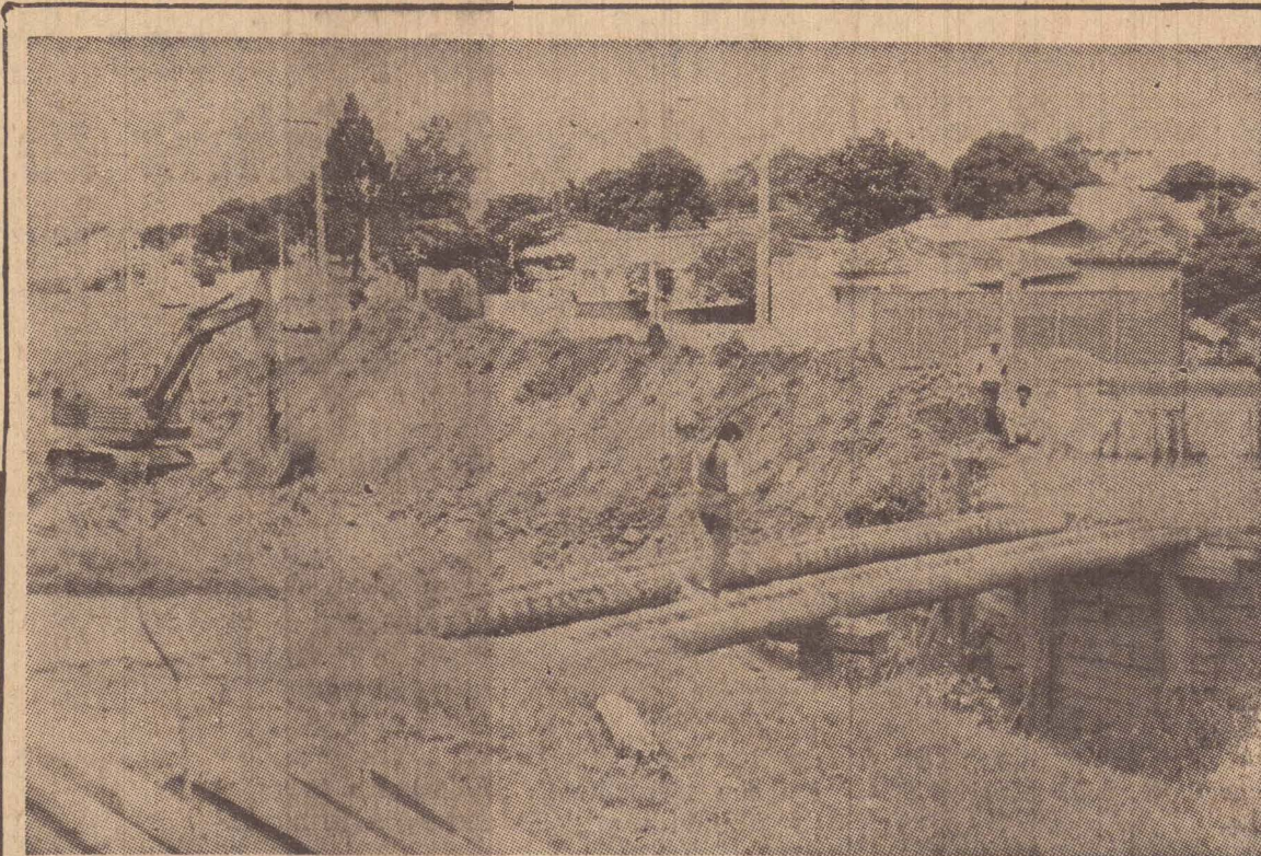
Os trabalhos já estão em andamento e o perfil do trecho já começa a ser modificado
