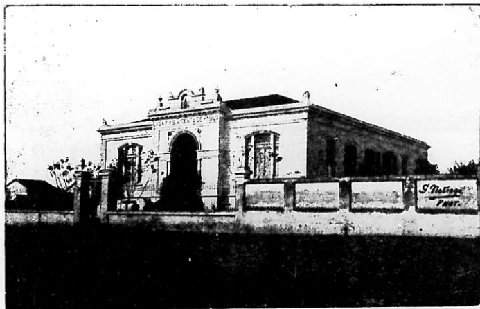
Aspectos de Avaré. — Casa Pia de S. Vicente de Paula
