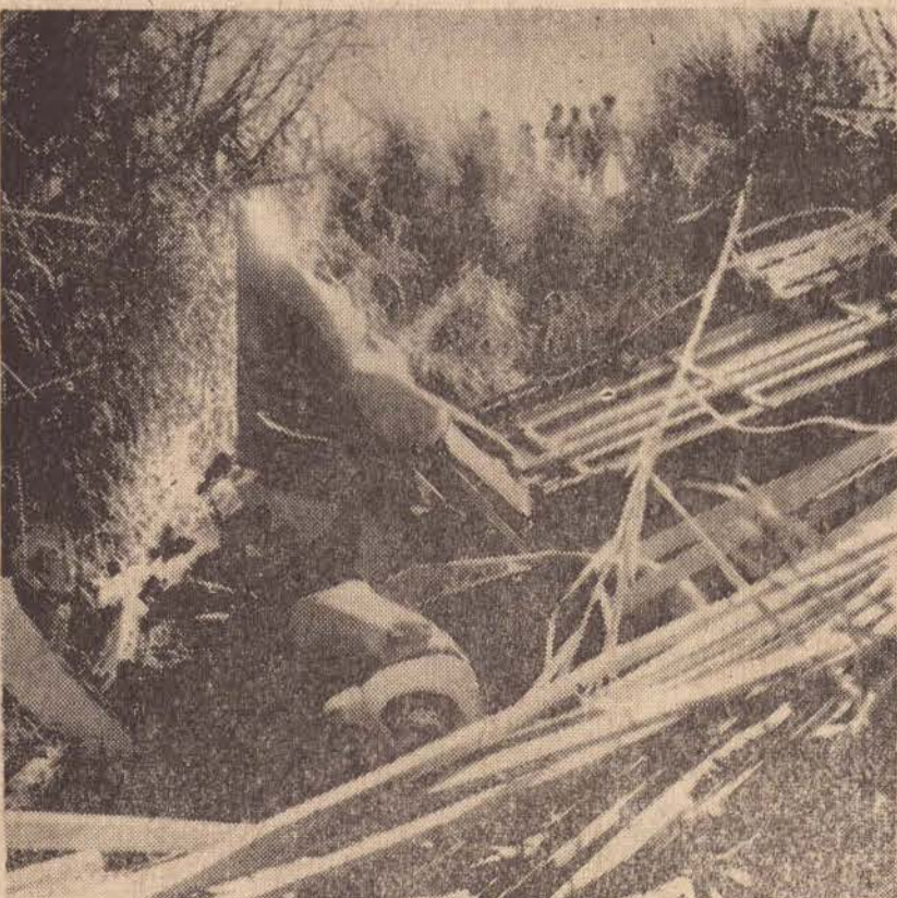
O próprio local em que pesadamente caiu o caminhão F-600 dificultou o trabalho de retirada dos cadáveres pela guarnição do Corpo de Bombeiros.
