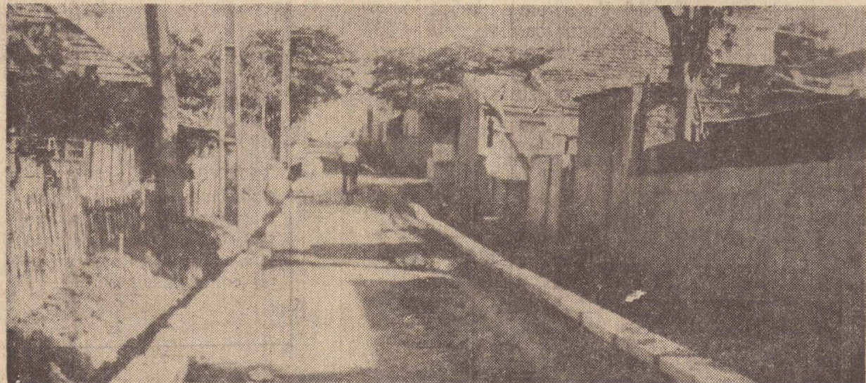
A rua da Instância, já está com a base, devendo receber a capa asfáltica até o final da semana
