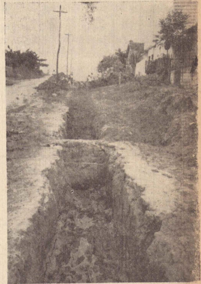
Na Avenida Ademar de Barros a rede de água está sendo estendida em toda sua extensão.
