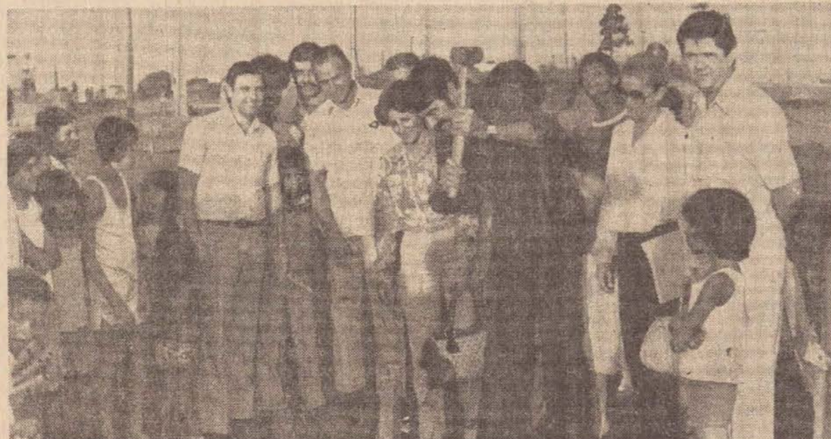
Momento em que o prefeito, oficialmente dava por iniciadas as obras da creche do Jardim Colina
