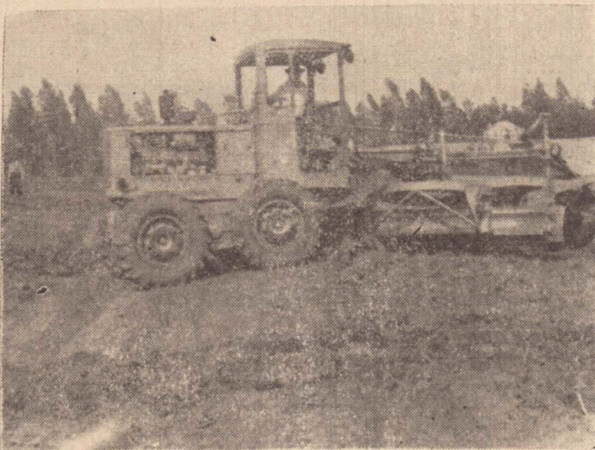
A motoniveladora executa todos os serviços na terra, para o plantio da amoreira.
