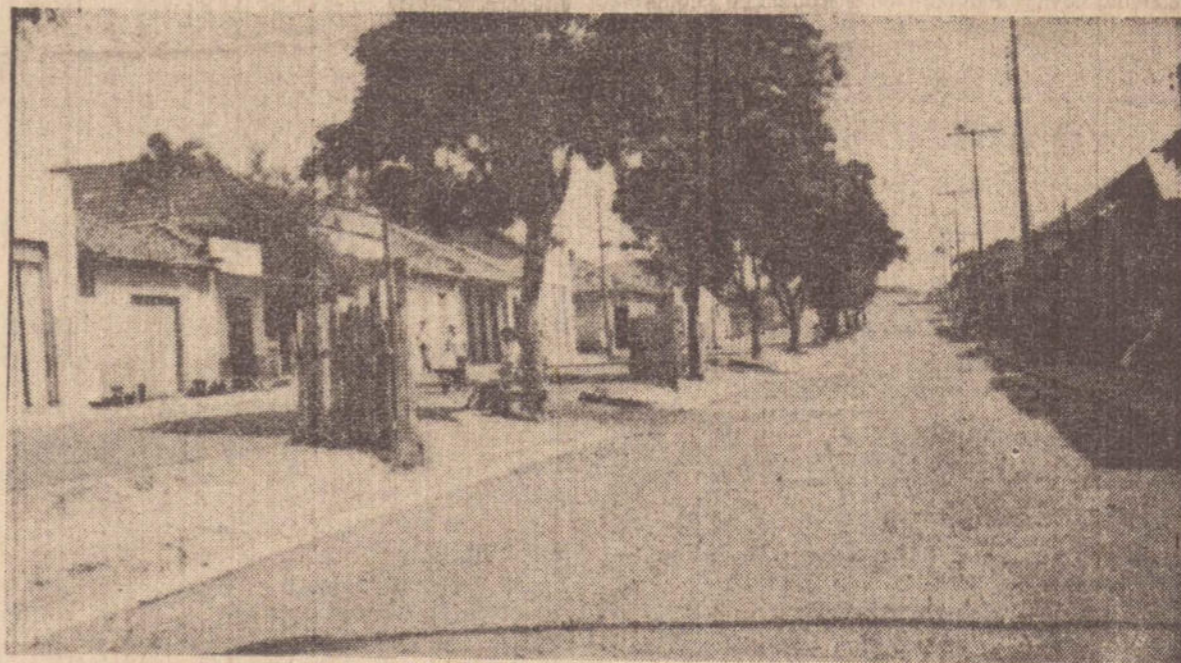
O novo aspecto da Av. São Paulo, no distrito de Cuiabá Paulista, após receber a pavimentação asfáltica.
