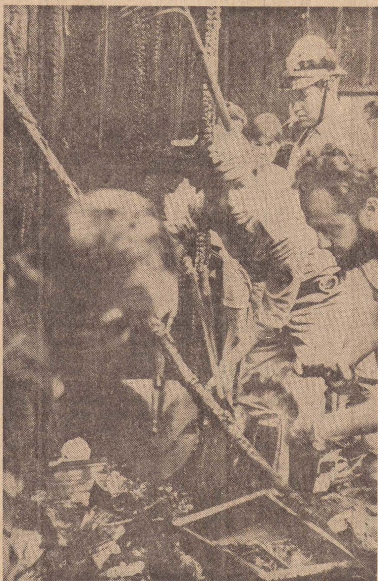
Nada pode ser aproveitado na casa incendiada.
