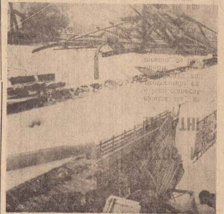
Aspecto parcial do depósito atingido pelo sinistro.
