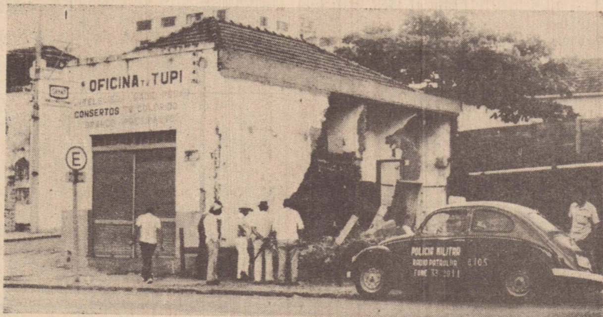
Quase toda a parede lateral da oficina veio a abaixo
