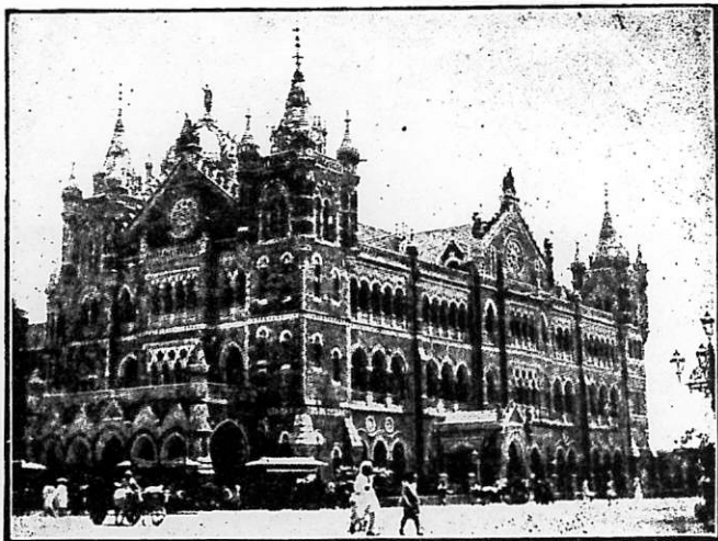
Estação ferroviaria de Bombay.
