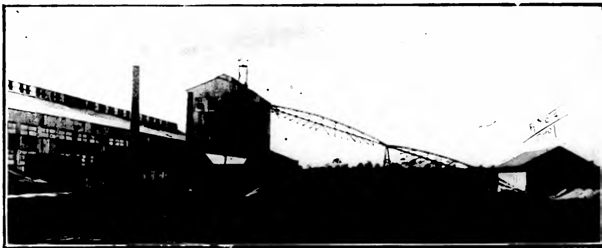
O grande elevador das Usinas Metallurgicas de Ribeirão Preto, o qual, recebendo o minerio e o carvão vegetal da Estrada de Ferro da importante empresa; o conduz ao alto de um forno electrico sueco destinado á fusão de minerio para convertel-o em aço liquido. Esse mineiro vem de Jacuhy, no Estado de Minas, sendo o carvão procedente de Gualapará e Sertãozinho, no Estado de S. Paulo.
