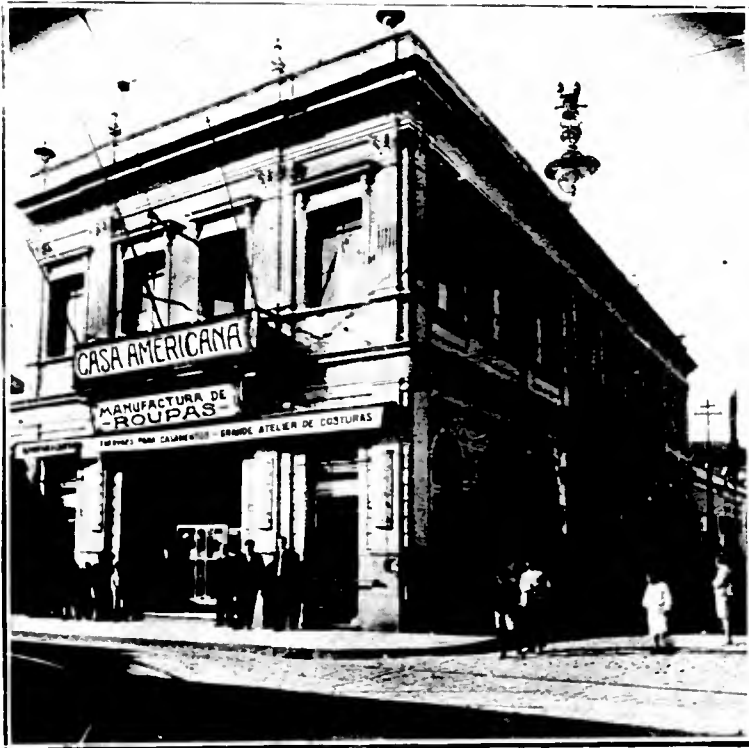
A fachada da importante CASA AMERICANA, installada a rua Barão de Jaguará n.º 63
