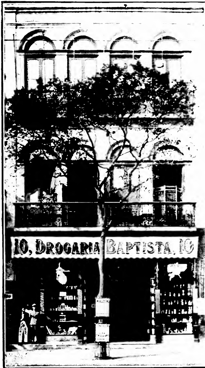
A fachada do novo predio onde funciona a Pharmacia e Drogaria Baptista, a rua 1.ª de Março n.º 10, no Rio
