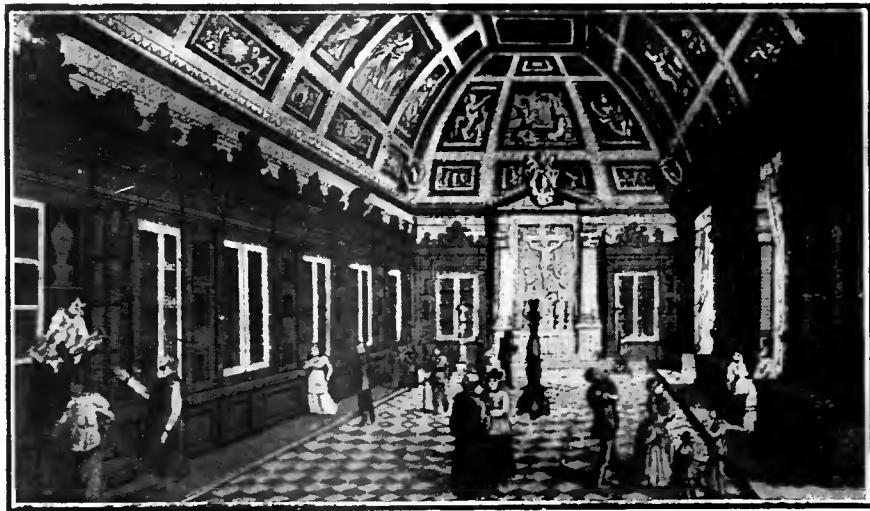
A Capella dos Theouros da Basilica de Nossa Senhora de Loreto, destruida por um terrivel incendio em Febereiro deste anno.
