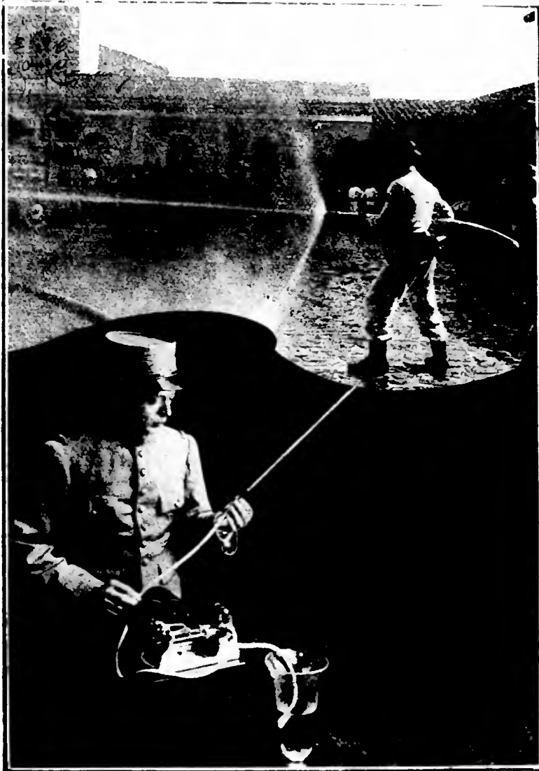
Em cima o aparelho "Suavisador", de invenção do capitão Affonso Cianculli, já adoptado pelo Corpo de Bombeiros e que consiste numa boquilha, a qual, sem prejudicar o facto, forma um leque de água que protege o bombeiro contra o calor das chammaes. Em baixo o capitão Cianculli demonstrando, na redacção d' "A Cigarra", as vantagens da sua engenhosissima "Bomba Independencia", aspirante e premente para extincção de incendios de huns industriaes.
