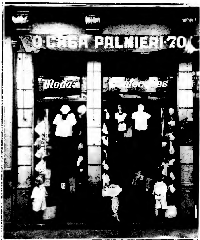
A fachada da Casa Palmieri, a rua Boa Vista n.º 70
