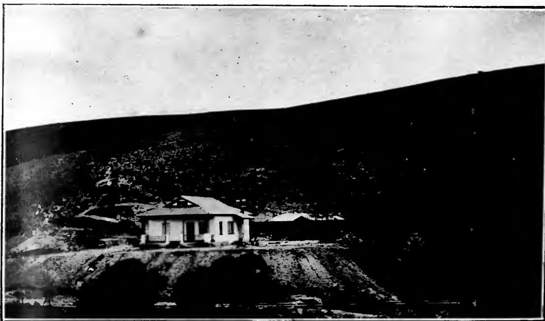
A pittoresca vivenda, em estylo «bungalow», de propriedade do sr. José Baptista Pereira de Almeida, construida num dos mais bellos e mais saudaveis pontos de Campos de Jordão. Eleva-se ao pé de uma collina, excellentemente batida pelo sol, abrigada dos ventos e é servida por uma nascente de magnifica agua. Está a 1.700 metros de altitude e della se descortina uma vista bellissima. Está ao lado do novo grande hotel em construcção para a Villa Inglesa, de Miss Baker, distante apenas um kilometro da Estrada de Ferro.
