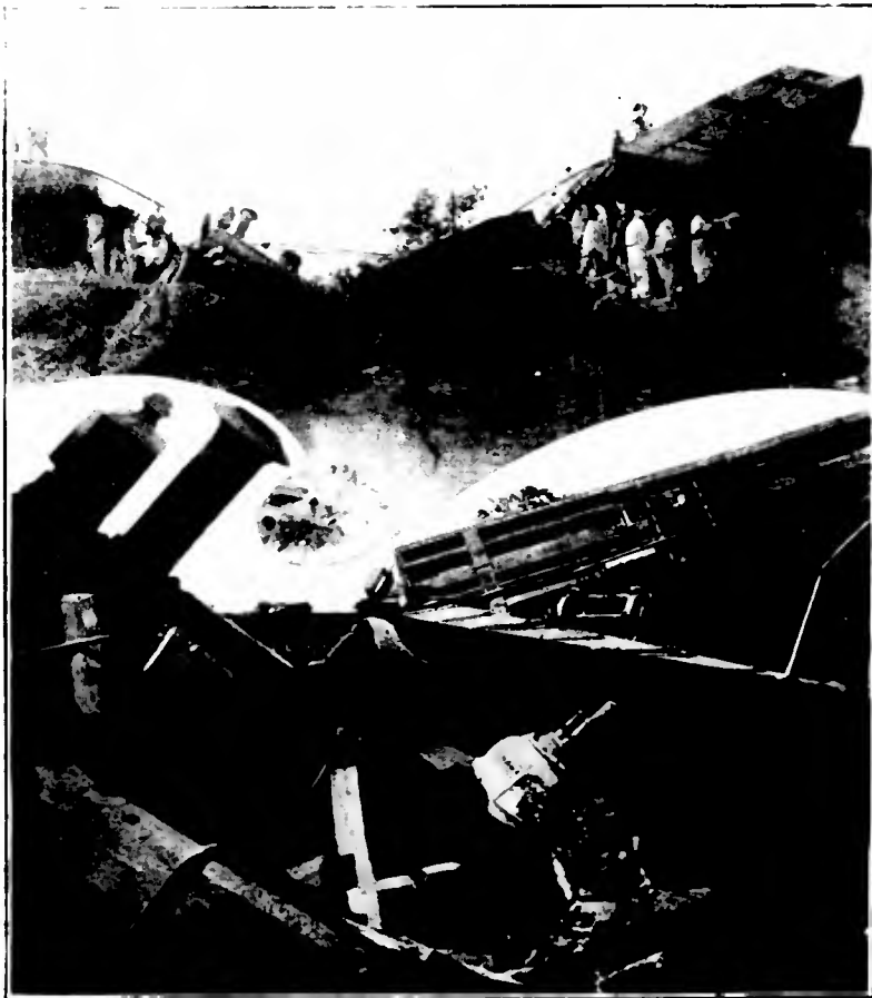
Photographias tiradas para "A Cigarra", após o desastre occorrido, a 27 de Marco ultimo, no ramal de Mocóca, da Estrada de Ferro Mogyana. O desastre occorreu ás 4 h2 da manhã, com o trem mixto que vinha de Casa Branca, o qual depois de haver passado pela estação de Hoby em direcção á de Engenheiro Róhe, se precipitou sobre um ribeirão, por ter corrido um aterro em consequencia das chuvas. Morreram o machinista e o foguista, nada tendo soffrido os passageiros, além do susto. O pobre machinista foi encontrado na posição de breacar o carro e dando contra-vapor. Os funeraes das victimas realisaram-se em Guaxupé, onde tinham sua residencia. O primeiro carro a cahir foi o vagão de carga, que ia cheio de carvão de pedra, arrastando com o seu peso a locomotiva, que já havia passado pelo aterro que ruiu.
