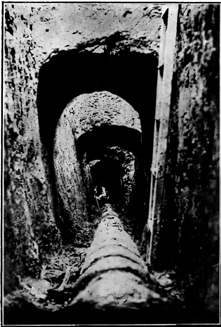
Aspecto da construção do Emissario da Rêde de Exgottos da cidade de Barretos, executada pela firma Barros, Oliva & Comp., Limitada, desta praça.
