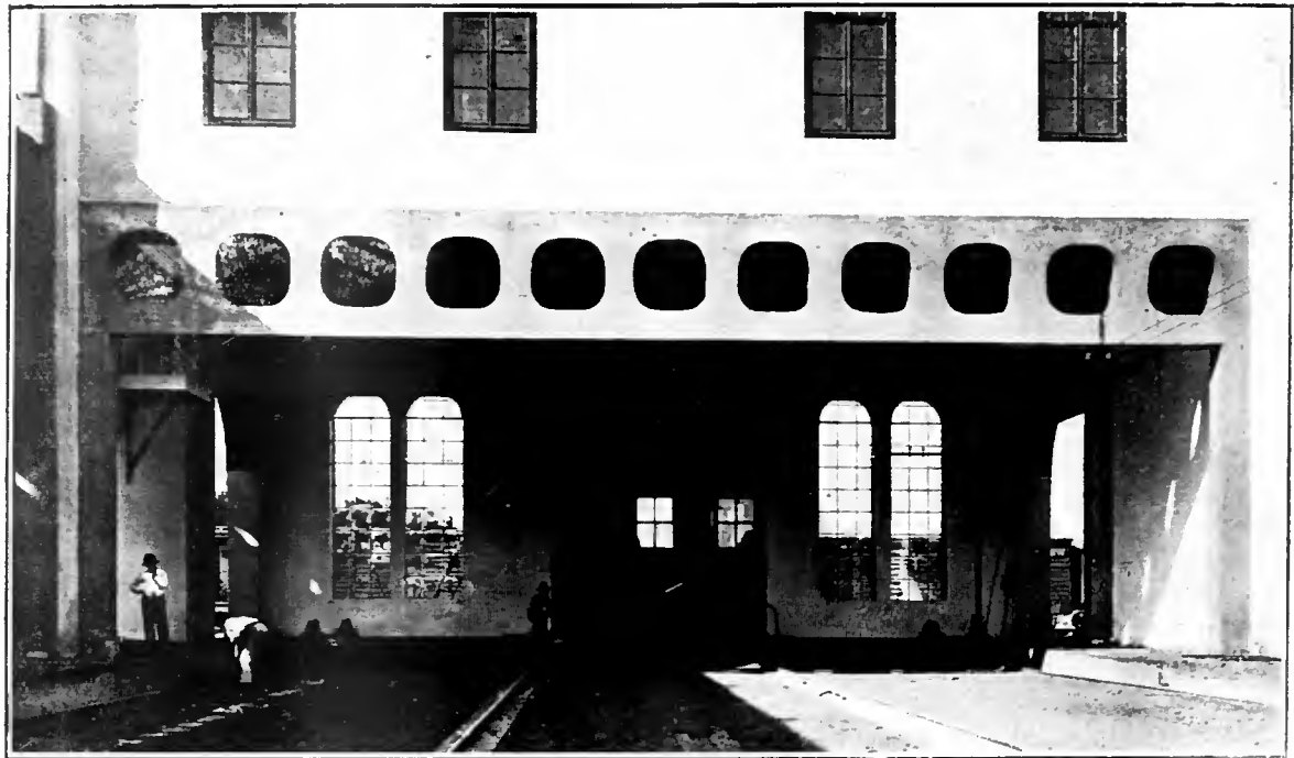
Vista interna das grandes Oficinas da Estrada de Ferro Noroeste do Brasil em Baurá, construídas pela acreditada firma Barros, Oliva & Comp., Limitada, tendo-se uma viga Vierendeel de 17 metros de vão, a qual é a primeira obra que neste genero se constroe na America do Sul.
