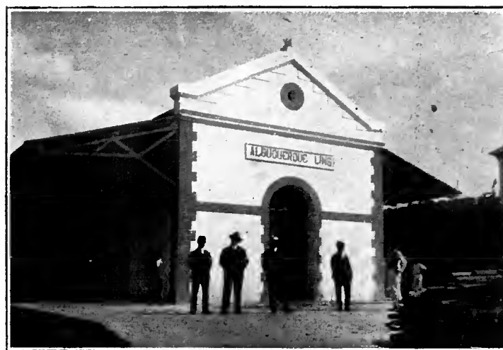
Uma das quatro estações ("Albuquerque Lins.") da Estrada de Ferro Noroeste do Brasil construidas pela firma Barros, Oliva & Cia., Ltda.
