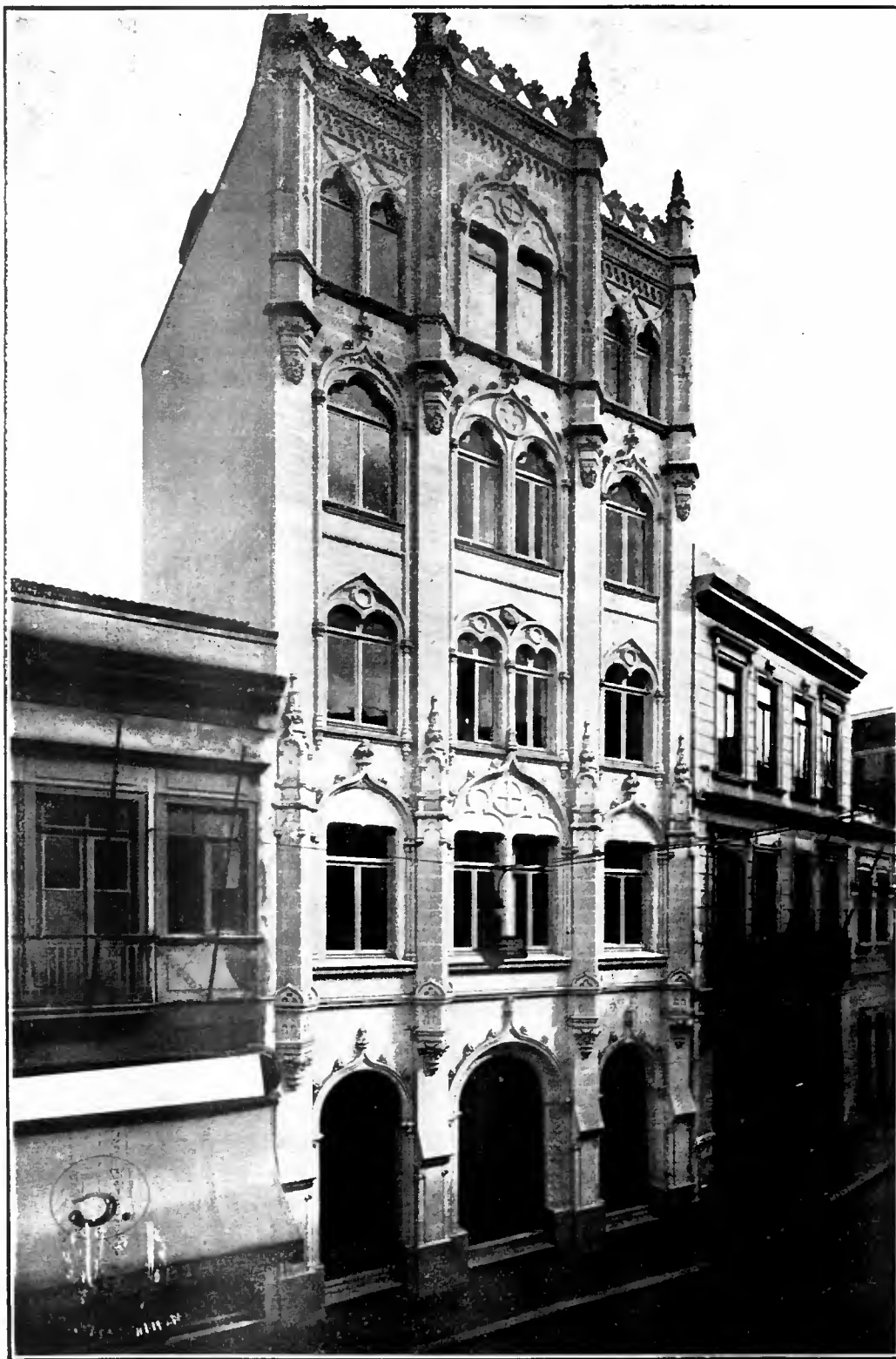
O novo edificio mandado construir especialmente para o Banco Nacional Ultramarino em S. Paulo, á rua Alvares Penteado n. 7, onde aquelle importante estabelecimento bancario já passou a funcionar.
