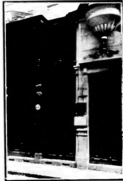
Um trecho da fachada do edificio onde funciona a "Companhia Comercio e Navegação" — á rua S. Bento, 45-A.
