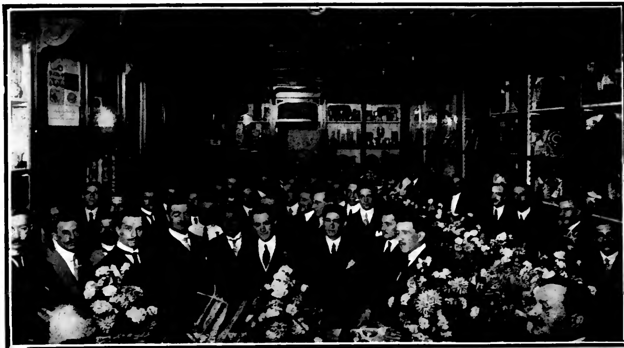
Aspecto da festa oferecida pelos proprietários da Loja do Japão aos seus convidados, representantes do alto commercio, industria, imprensa, etc., por ocasião da inauguração de suas novas instalações, no dia 17 do corrente, no grande prédio da rua de S. Bento esquina da rua Alvares Penteado. Vê-se a secção de atacados onde foi servida uma mesa de doces, profusamente enfeitada de flores.
