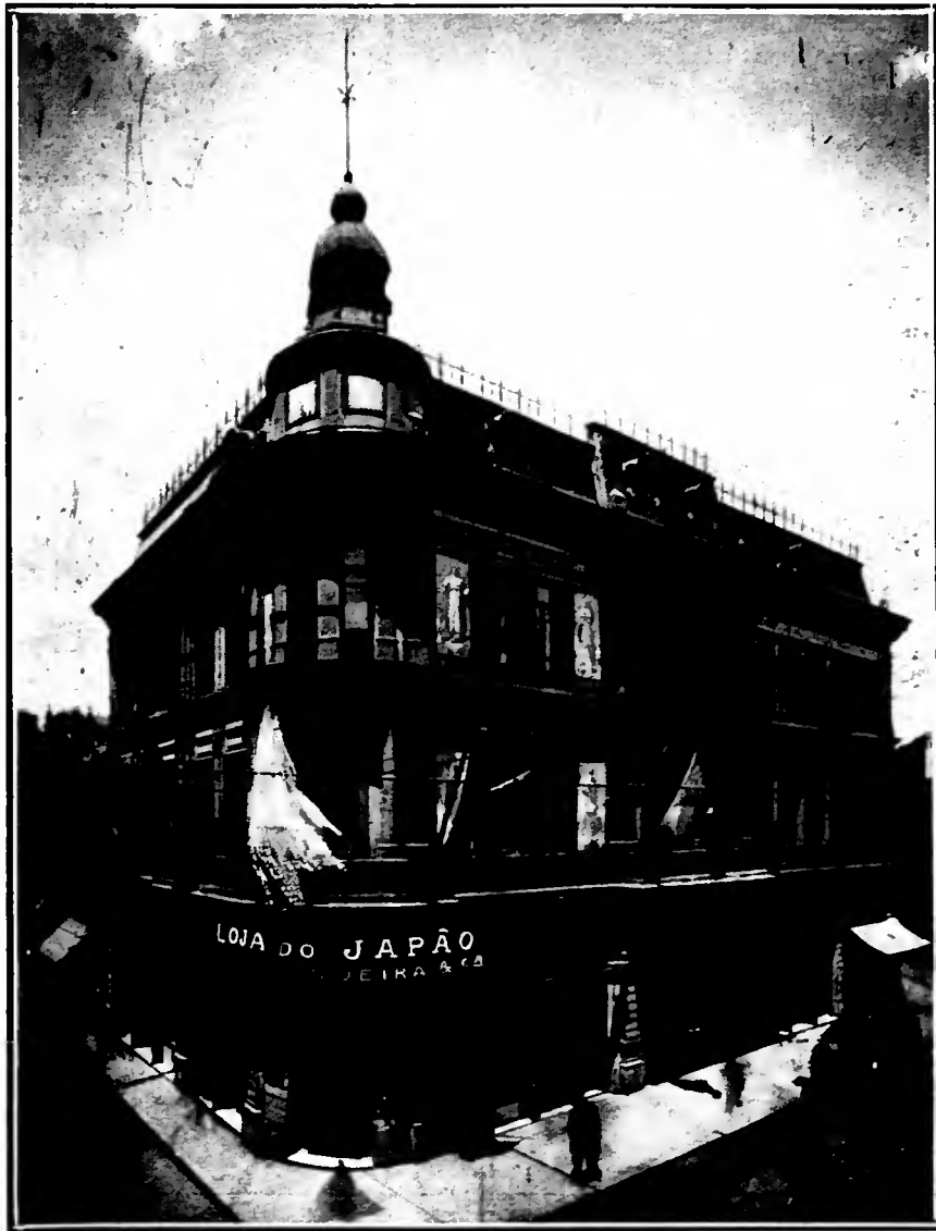
A fachada do novo predio em que funciona a Loja do Japão e o Banco do Minho, á rua de S. Bento, esquina da rua Alvares Penteado, recentemente inaugurado
