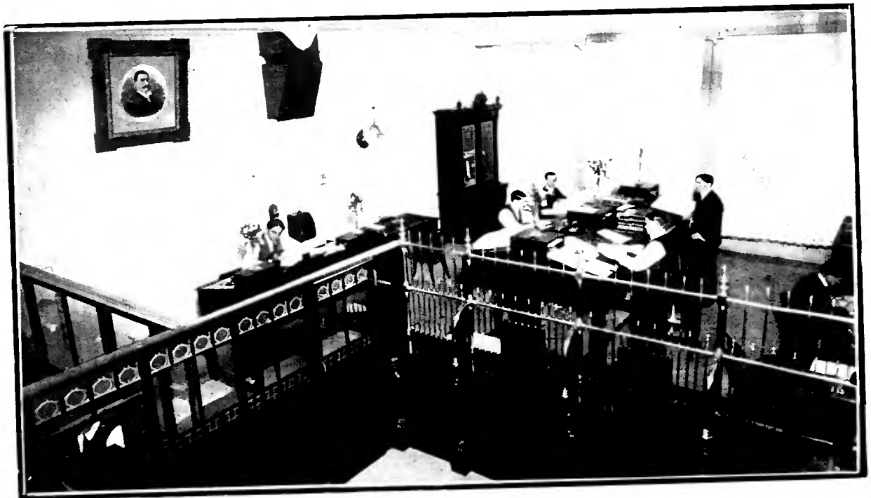
Os escriptorios da Loja do Japão e Banco do Minho, confortavelmente installados no primeiro andar do novo predio
